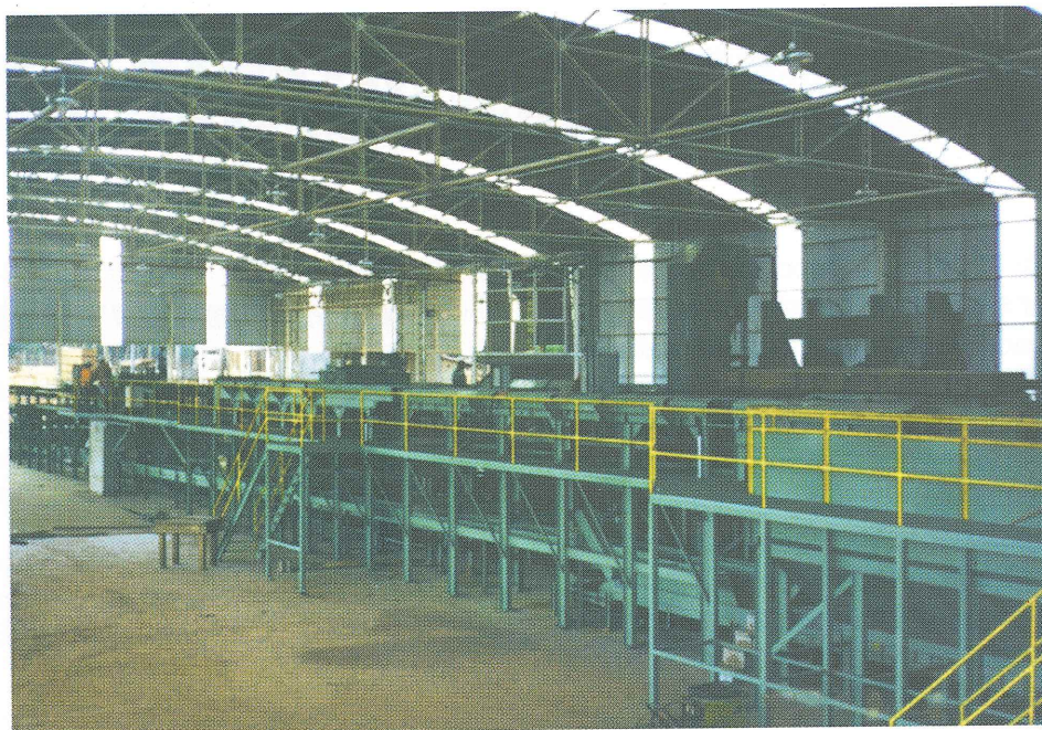
A vista parcial de uma serraria de grande porte
